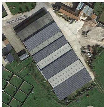
Toiture PV agricole à Bellancourt 2
